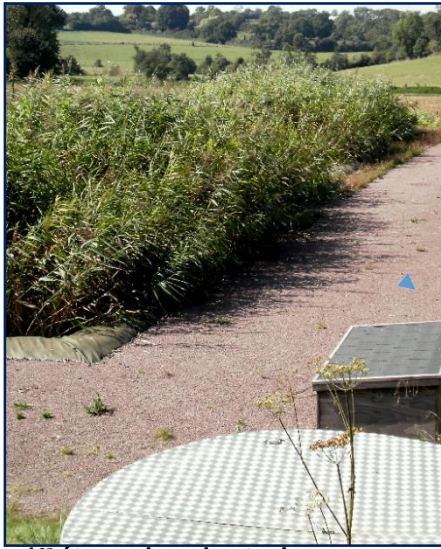
1 er étage : bac de stockage, bassins A et B
